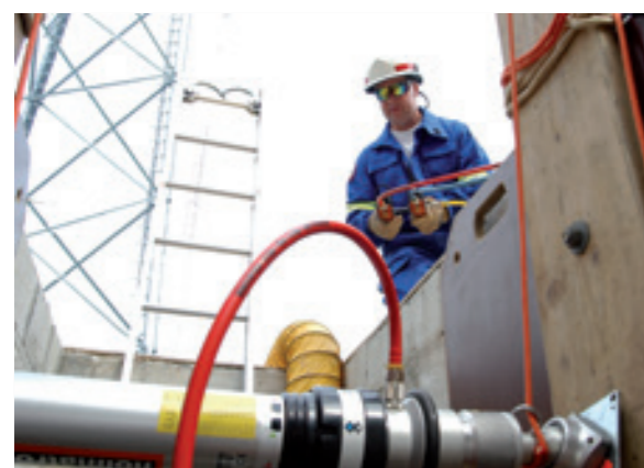
Escoramento remoto numa vala.
