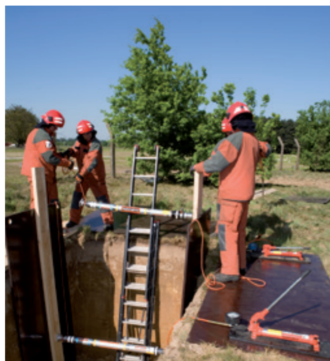
Cilindros hidráulicos utilizados num escoramento remoto.
