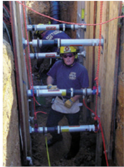
Resgate em valas
