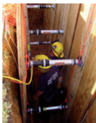
Escoramento de vala com cilindros pneumáticos autoblocantes.
