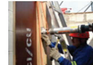
Utilizar uma cabeça inclinada com placa de fixação em escoramento de valas.
