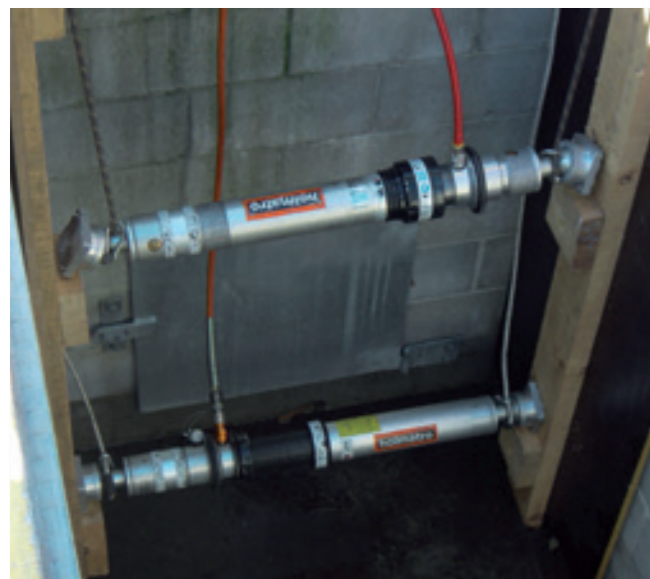
Escoramento remoto com cilindros autoblocantes.
