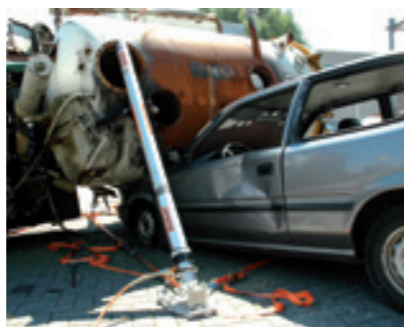
Estabilização de veículos pesados com cilindros hidráulicos com contra-porca.
