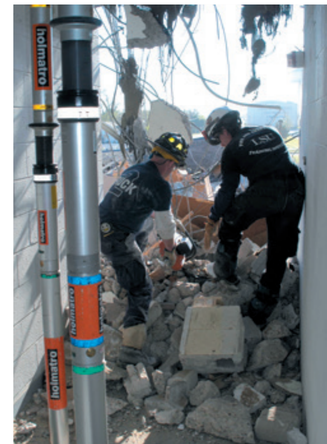
Estabilização de edifício desmoronado com cilindro manual com contra-porca.
