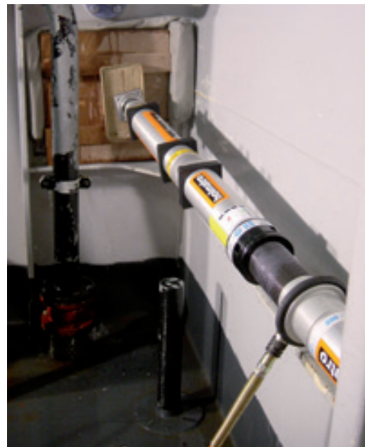
Selagem de fuga numa parede divisória com uma escora hidráulica do sistema PowerShore.
