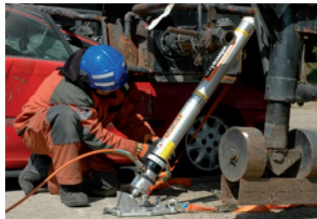
Os escoramentos podem colocar-se em diversos ângulos.
