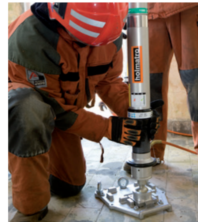
Cilindro pneumático com contra-porca utilizado como cilindro manual para escorar um edifício.
