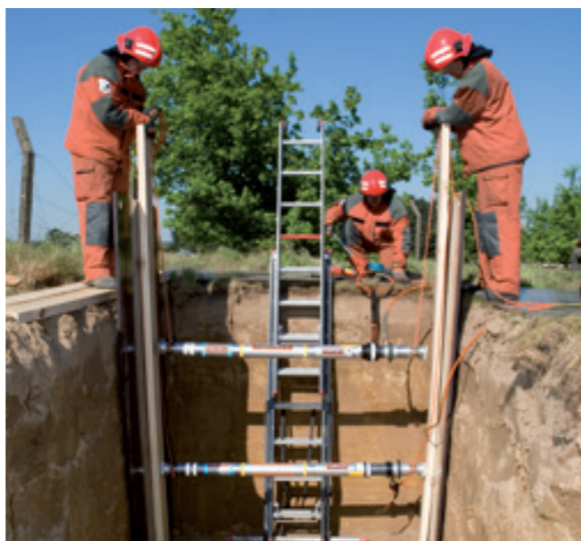
Escoramento remoto com cilindros hidráulicos autoblocantes.
