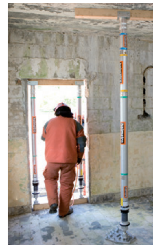
Cilindros combinados com madeira, protegendo as rotas de acesso e saída de um edifício colapsado.
