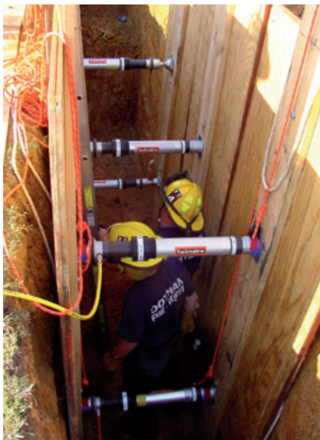
Escoramento de uma vala com cilindros pneumáticos autoblocantes.
