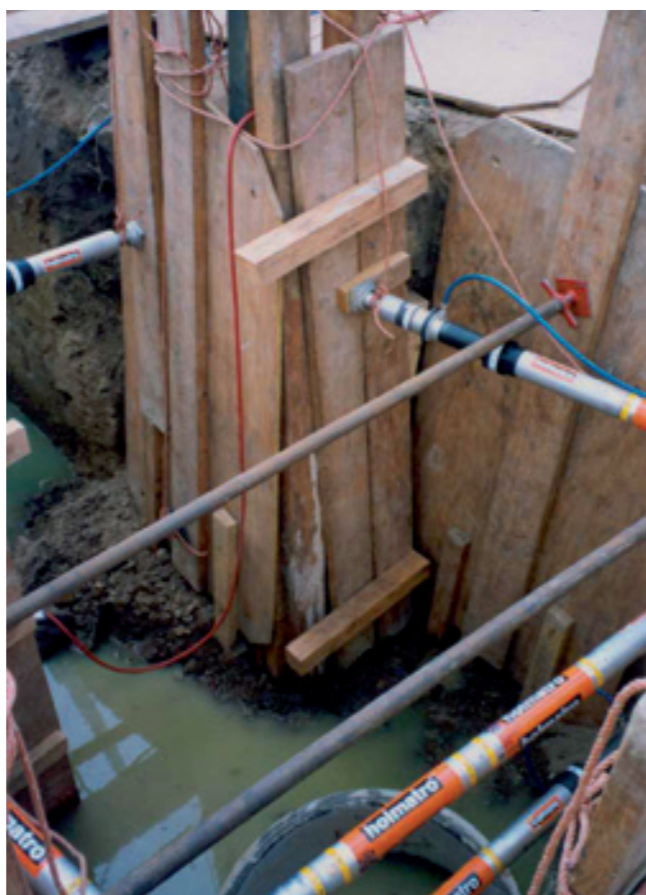
Cilindros pneumáticos autoblocantes colocados numa vala.
