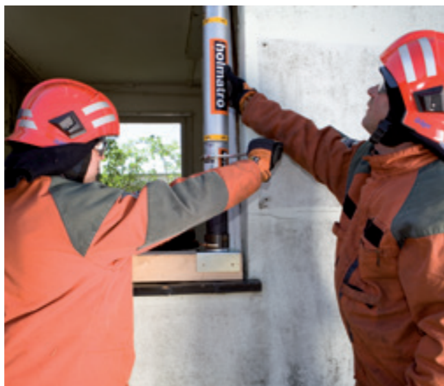
Cilindro manual roscado utilizado para escorar uma janela. Pode ajustar-se com uma chave de gancho (ver imagem inferior).
