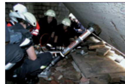
Estabilização e elevação, com cilindro hidráulico com contra-porca, de uma estrutura colapsada.
