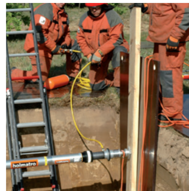
Os cilindros pneumáticos são muito úteis para escoramentos remotos em resgates em valas.
