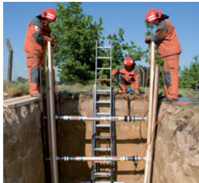
Stutten op afstand met hydraulische Auto-lock stutten.
