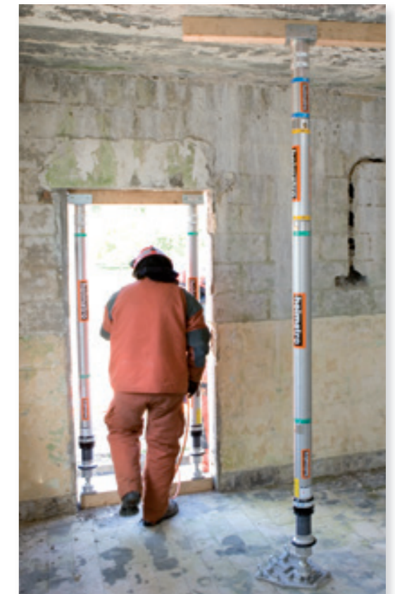
Stutten gebruikt met balken om de toegang- en uitgangroute van een ingestort gebouw te beschermen.
