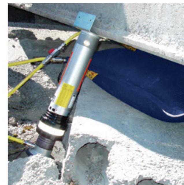
Auto-lock stut in gebruik als back-up van een hefkussen.
