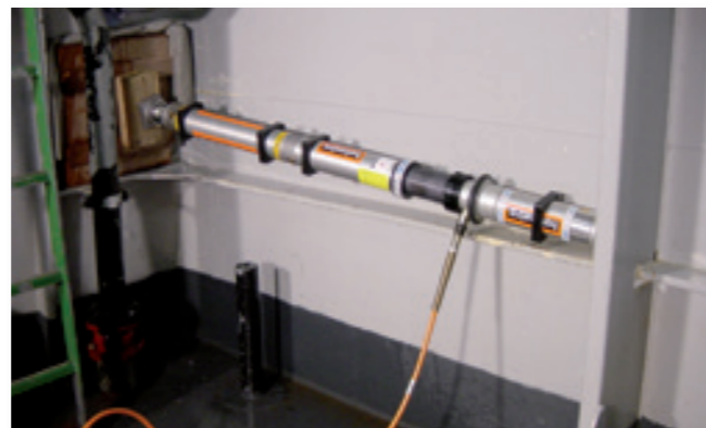
Hydraulische stutten gebruikt met verlengpijpen, koppen en hout om een lek aan boord af te dichten.
