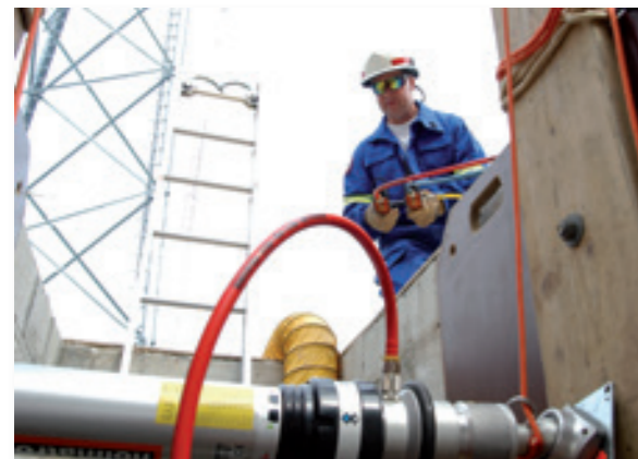
Stutten van een greppel op afstand.
