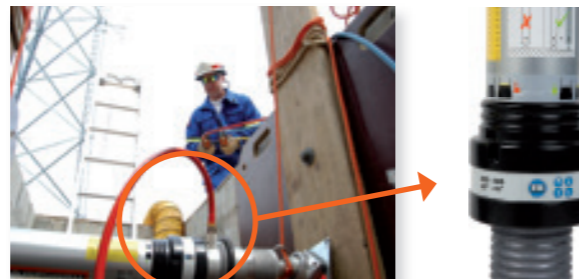
Het Auto-lock systeem maakt stutten op afstand mogelijk.
