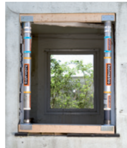
Handbediende stutten met verlengpijpen, balksteunen en balken gebruikt in een raamopening.
