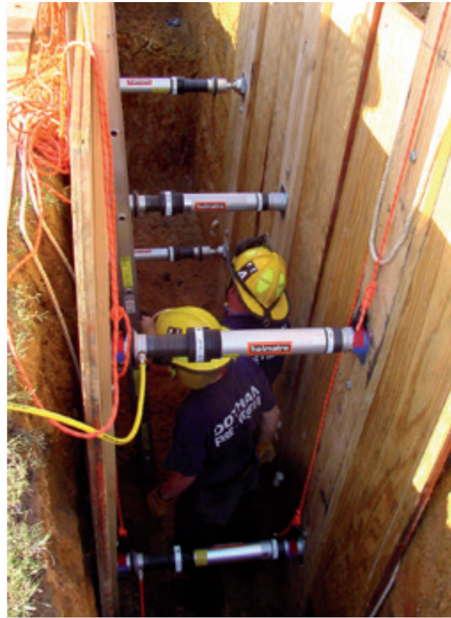
Greppel gestut met pneumatische Auto-lock stutten.
