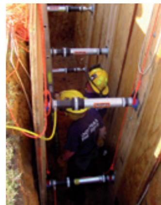
Stutten van een greppel met pneumatische Auto-lock stutten.
