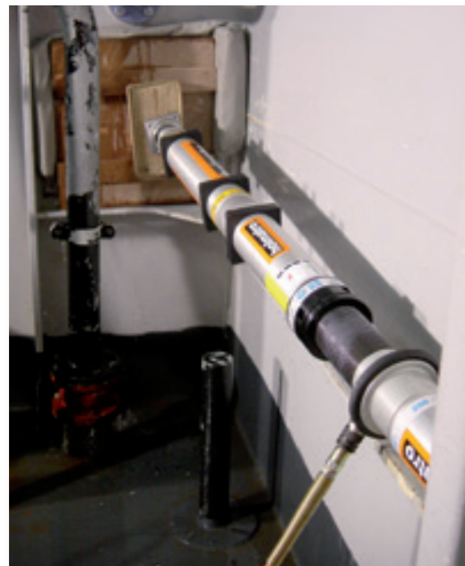
Lekafdichting in een scheidingswand met het hydraulisch PowerShore systeem voor de Marine.
