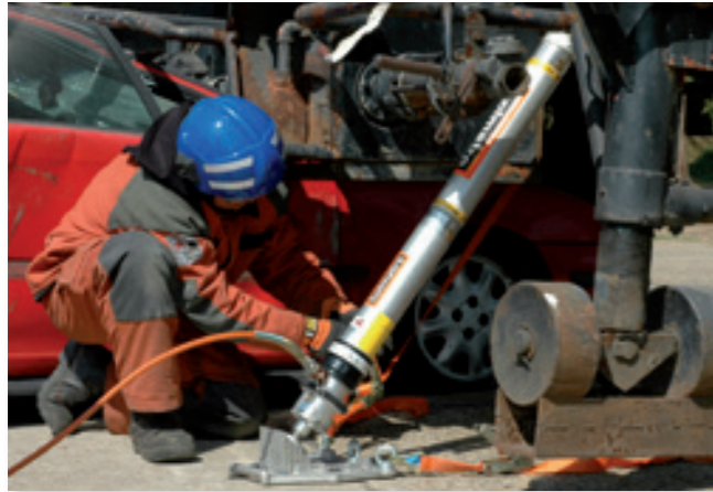
De stutten kunnen onder diverse hoeken worden geplaatst.
