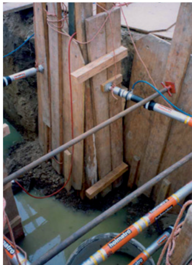
Pneumatische Auto-lock stutten in een greppel.
