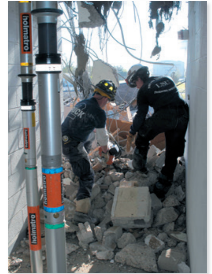
Het stutten van een ingestort gebouw met een handmatig borgmoersysteem.
