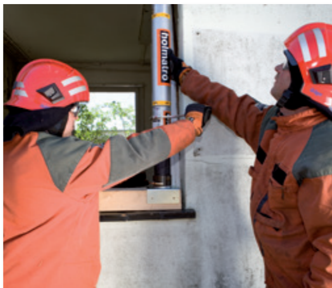
Het gebruik van een handbediende stut met zelfborgend schroefdraad voor het stutten van een raam. Dit type wordt vergrendeld m.b.v. een haaksleutel.
