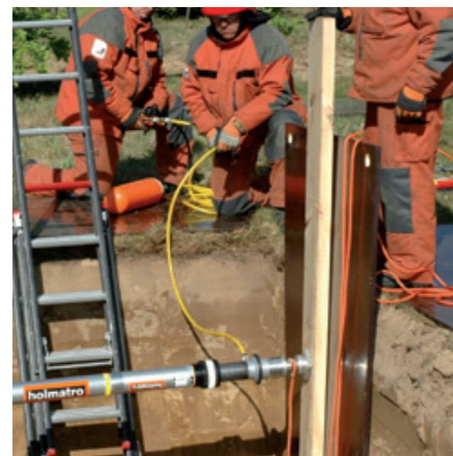
Pneumatische Auto-lock stutten zijn zeer geschikt voor het stutten op afstand van ingestorte greppels.
