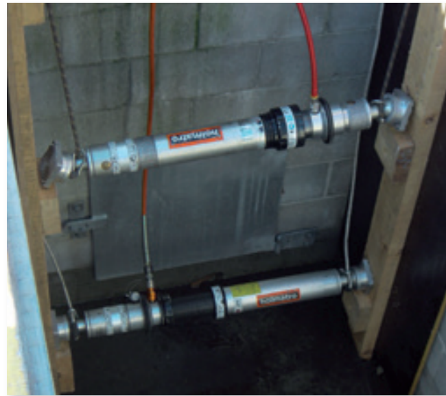
Stutten op afstand met Auto-lock stutten.
