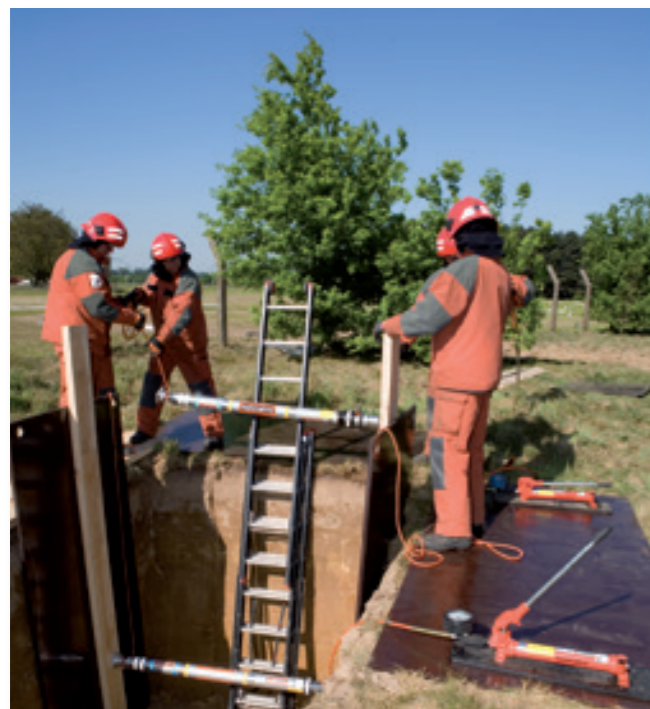
Hydraulische Auto-lock stutten gebruikt voor stutten op afstand.
