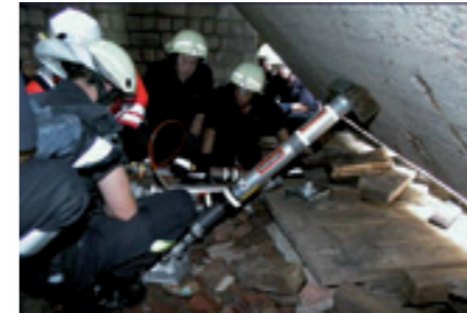
Het stutten en heffen van puin met een hydraulisch borgmoersysteem.
