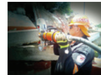
Eine perfekte Kombination: Beton mit dem CC 23 wegbrechen und Betoneisen mit dem Minischneidgerät CU 4007 oder SMC 5006 schneiden.
