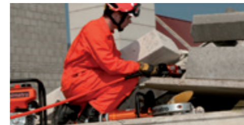
Eine perfekte Kombination: Beton mit dem CC 23 wegbrechen und Betoneisen mit dem Minischneidgerät CU 4007 oder SMC 5006 schneiden.
